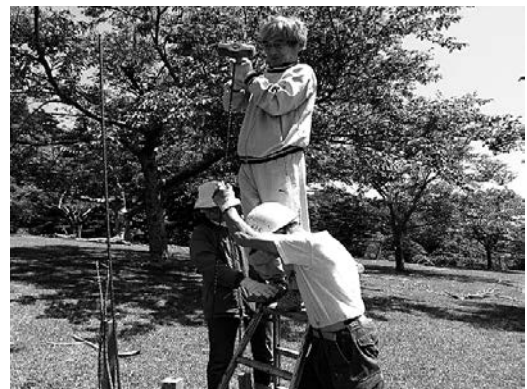
防シカ柵の補修
