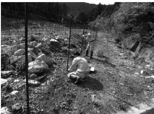
獣害防止柵を設置
