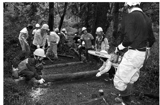
丸太の階段設置
