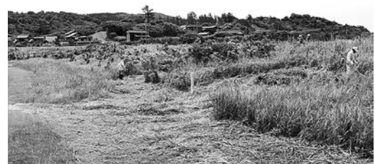
法面の刈払作業
