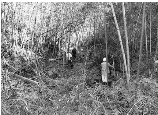
通路整備作業
