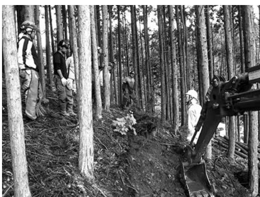
作業道敷設研修
