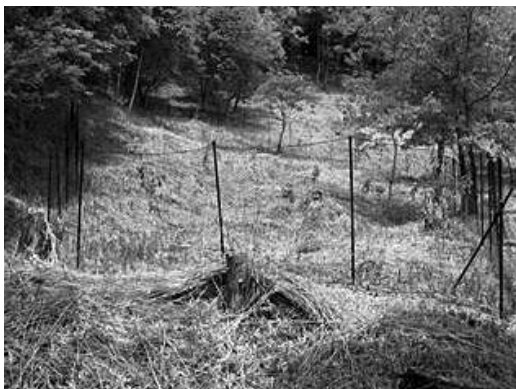
防シカ柵設置
