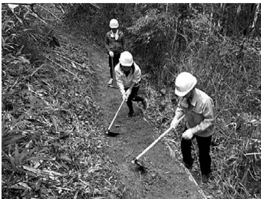
作業道の補修
