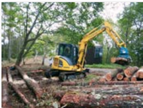
専門業者によるアカマツ伐採・地拵え
