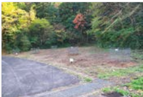
植栽木を獣害から守る侵入防止柵を設置
