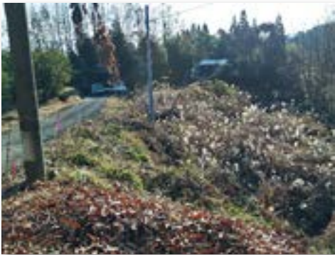
造成工事前の市道
