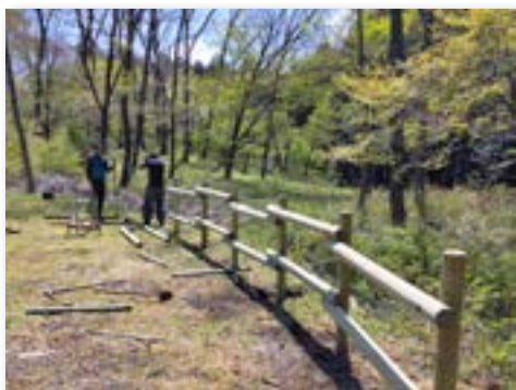
安全柵設置の様子
