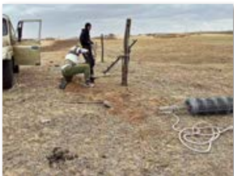
金網防護柵設置作業 (ホンシャンドーク沙地)
