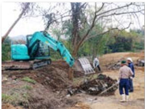
荒れた土地のガレキを撤去して拡張地の整備
