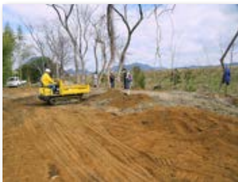
花崗土を投入して植樹準備作業
