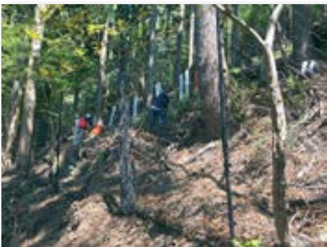
防獣ネットを設置
