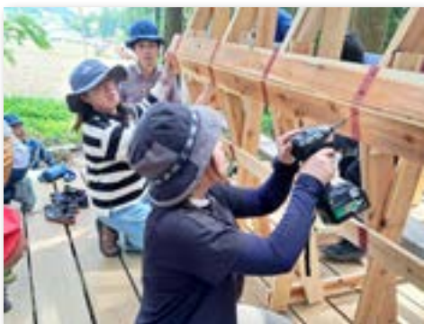
トラスの組み立て
