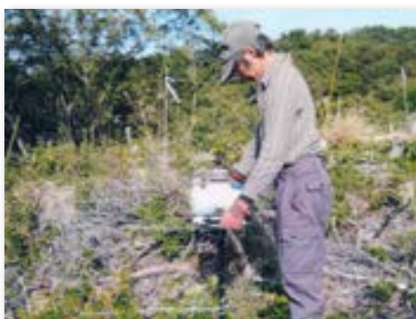
植樹場所のオーガーによる穴掘り作業
