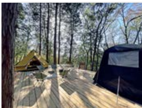
完成したデッキ
