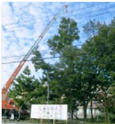
クレーンを使用した高木の伐採作業
