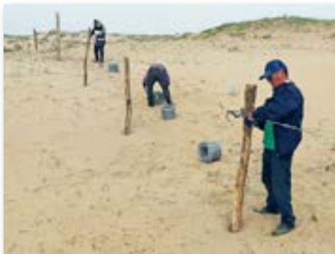
家畜などから樹木を守るため柵を設置
