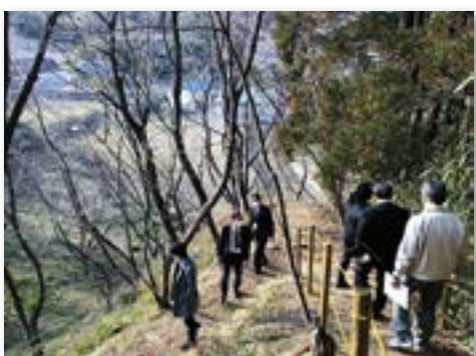
補修した遊歩道
