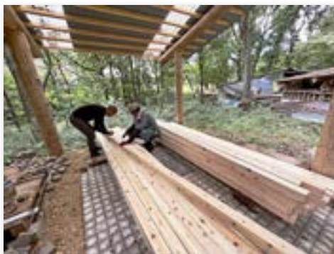
間伐材を製材しデッキに使用
