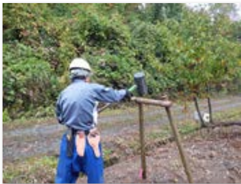
支柱を立てる
