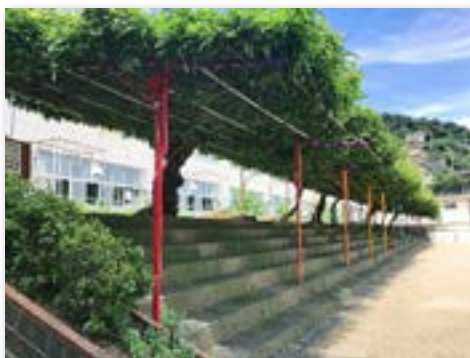
藤棚鉄骨丸柱工事後
