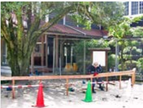
ギンモクセイ囲いの修繕
