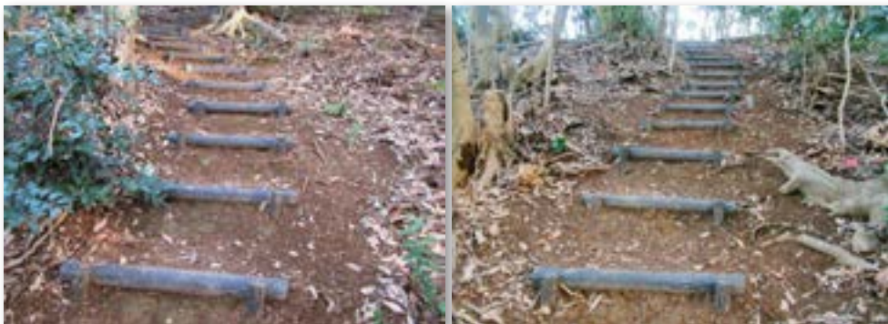
遊歩道完成状況
