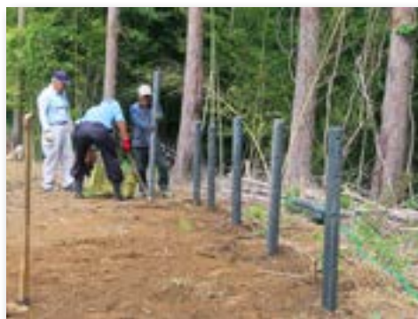
遊歩道に安全杭を設置
