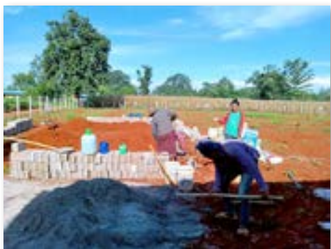
モデルファームのための堆肥小屋建設の様子
