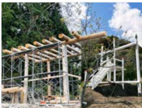
ツリーハウスの骨組み(左)、完成したジップライン(右)
