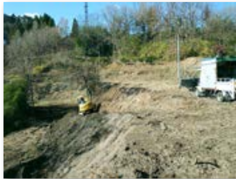
重機による坂道の作成作業
