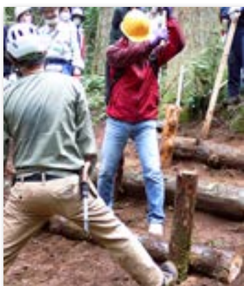
崩れかかった斜面に階段づくり
