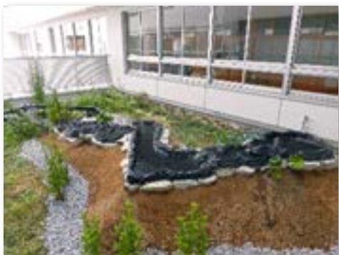
完成したビオトープ
