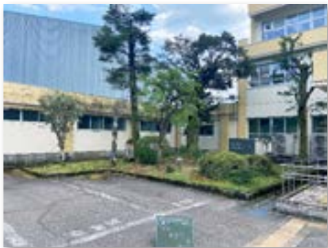
校舎付近の樹木の手入れ後の様子
