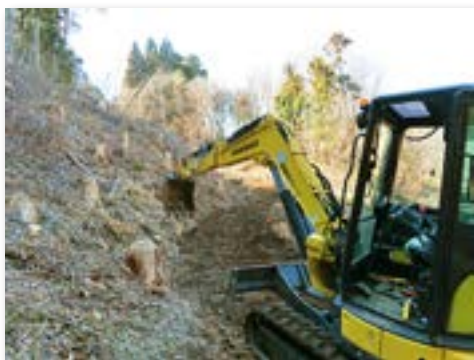
重機による遊歩道粗造り
