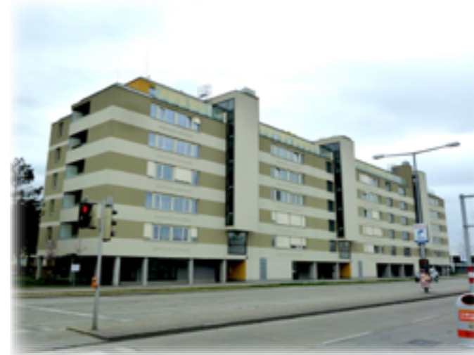
木造高層ビル時代のあけぼの 地球温暖化の緩和へ向けて、イノベーションが求められる現代において、木造高層ビルの建設は、世界の潮流となりつつある。写真は、CLTを使って建てられた木造中層建築物のさきがけとなったオーストラリアの7階建て木造マンション。
