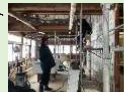
リノベーション作業中
